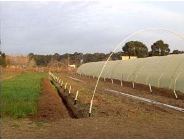
Zanja abierta para sujetar el PE del techo
