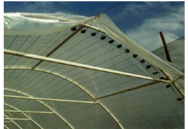
Vista de torniquetas en el extremo del Túnel alto
