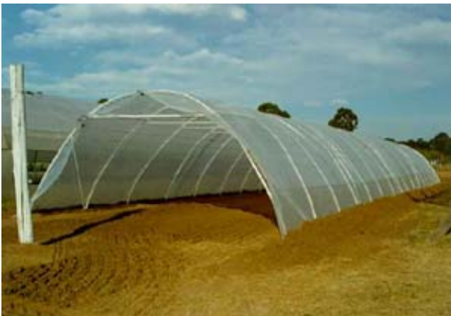
Vista del frente con poste de sujeción
