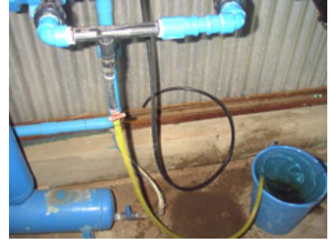
Sistema de inyección de fertilizante "Venturi"
